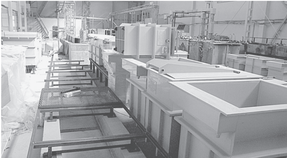
РАБОТА ИДЁТ. На площади примерно около 3000 м 2 установят 136 гальванических ванн.
