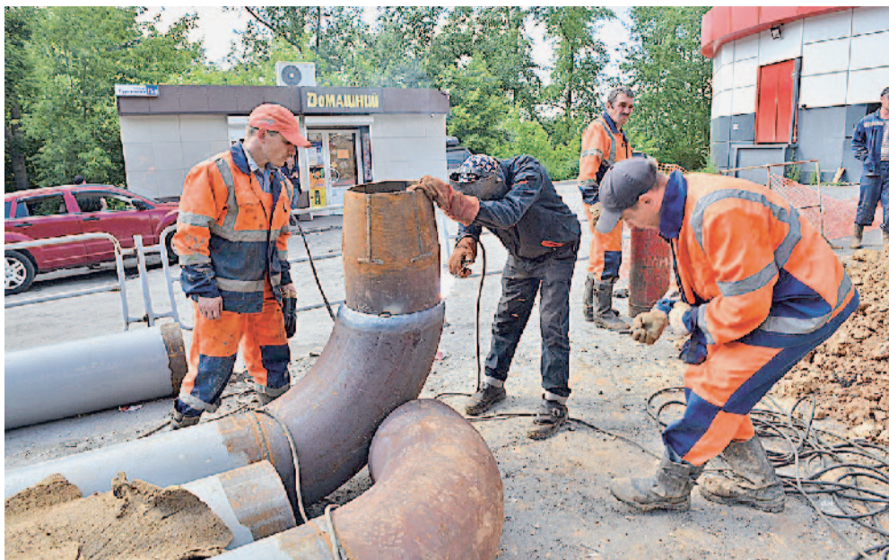
Замена труб на ул. Тургенева
